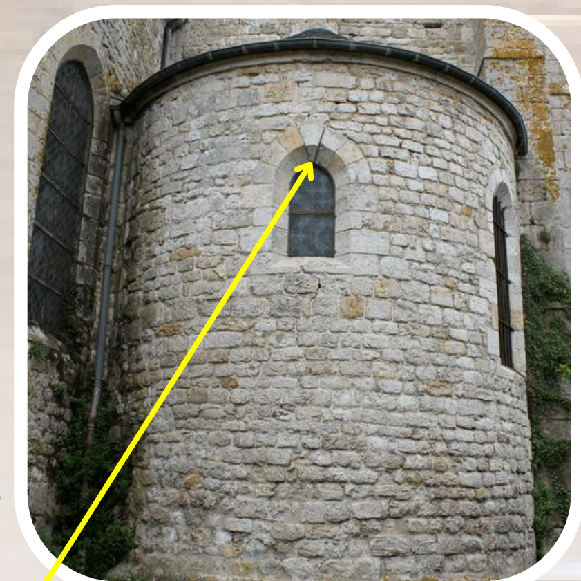
Vue de l'ancienne Absidiale (qui est l'actuelle Sacristie), avec vue sur son extérieur.
