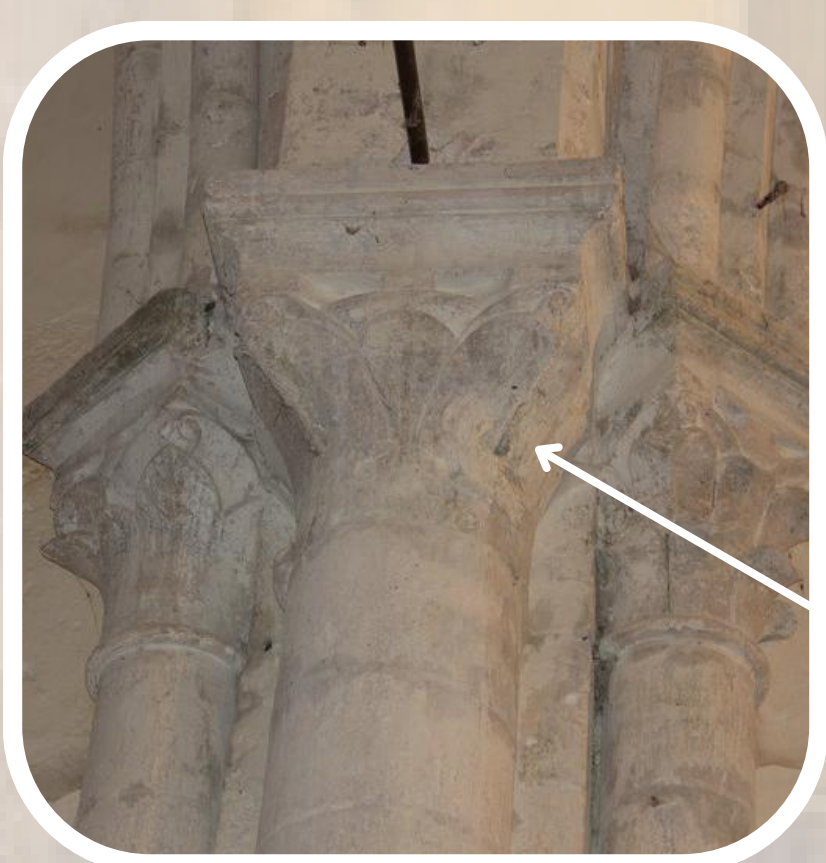
Photographie avec vue en détail sur un Chapiteau de Style Corinthien. Nous remarquons également les Feuilles d'Acanthes.
