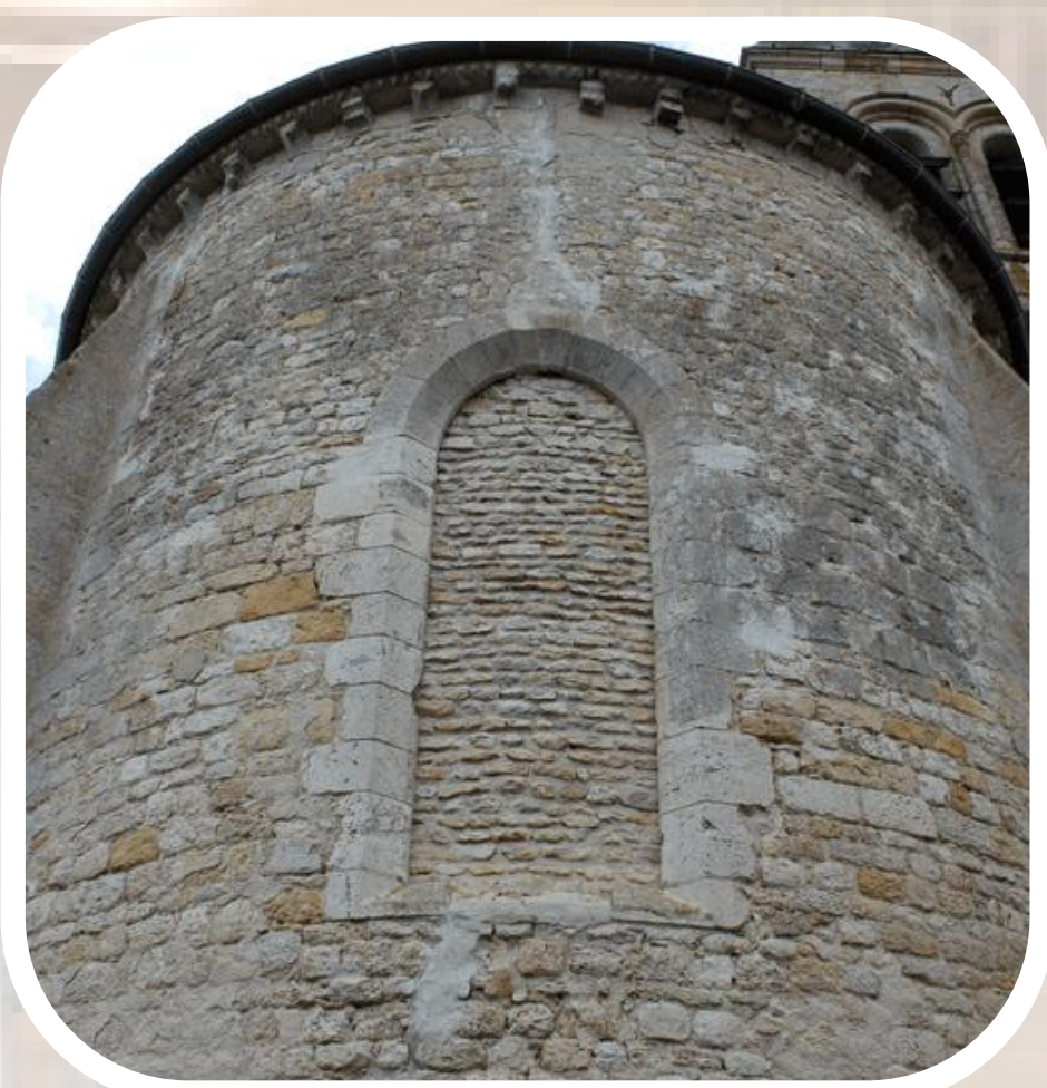
Photographie représentant l'ouverture Est de l'église, mais qui est cachée par le Retable.
