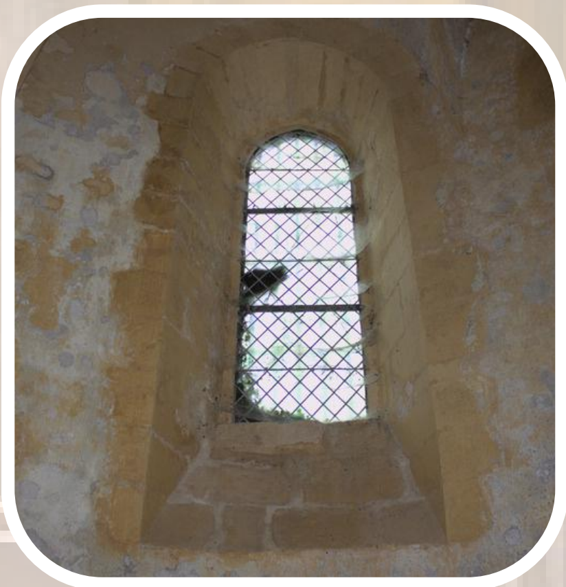
Photographie d'un des deux vitraux situés dans l'église. Nous pouvons remarquer qu'à son extérieur, se trouve une protection de plusieurs barres en métal.
